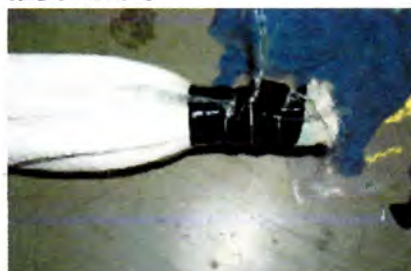
先端部固定状況
